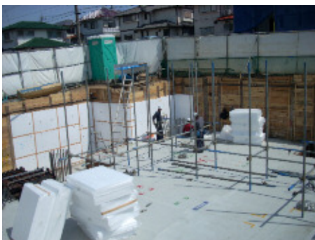
山止め側のスタッドボルトを利用しビブランを貼り付け、固定する
