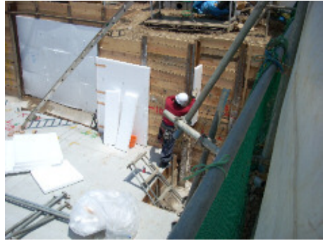
山止め側のスタッドボルトを利用しビブランを貼り付け、固定する
