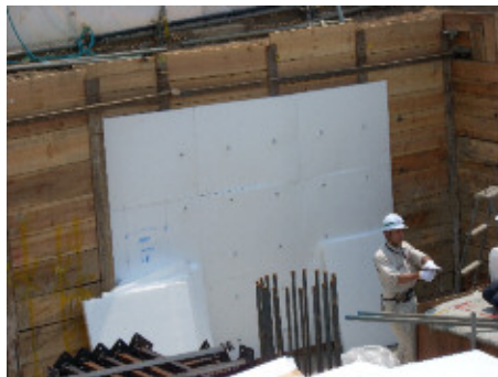
山止め側のスタッドボルトを利用しビブランを貼り付け、固定する
