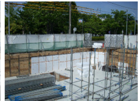
山止め側のスタッドボルトを利用しビブランを貼り付け、固定する
