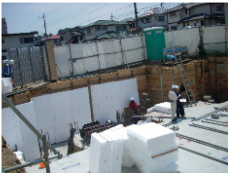
山止め側のスタッドボルトを利用しビブランを貼り付け、固定する
