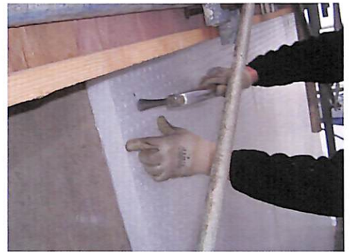
釘打ち（表面から5mm打込む）
