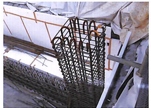
養生テープ貼付け
